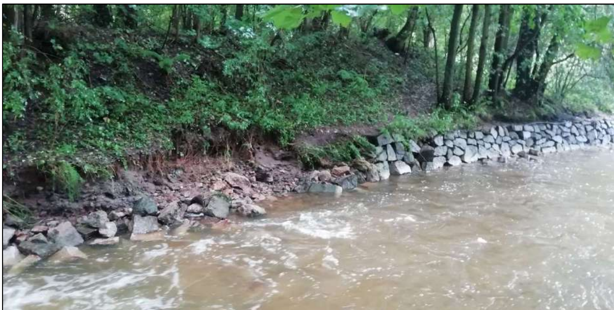
Obr. 10: Rozsah poškození LB rovnaniny v nátoku do zátopy hlavní nádrže VD Fojtka (napojení a struktura původní rovnaniny) (9/2024)
