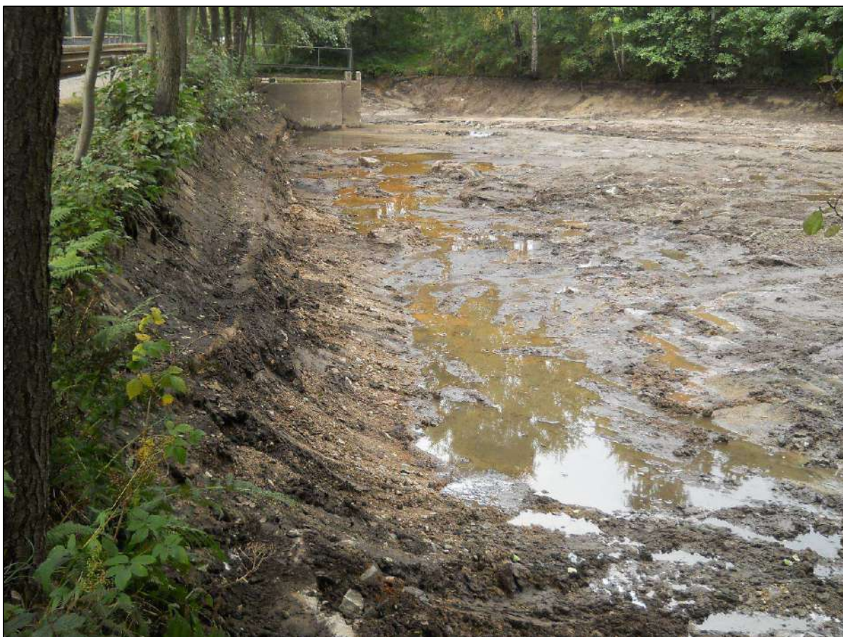
Obr. 3: Stav přehrážky krátce po předcházejícím odtěžení nánosů – dlažba na návodním líci hráze, včetně patky (9/2011)
