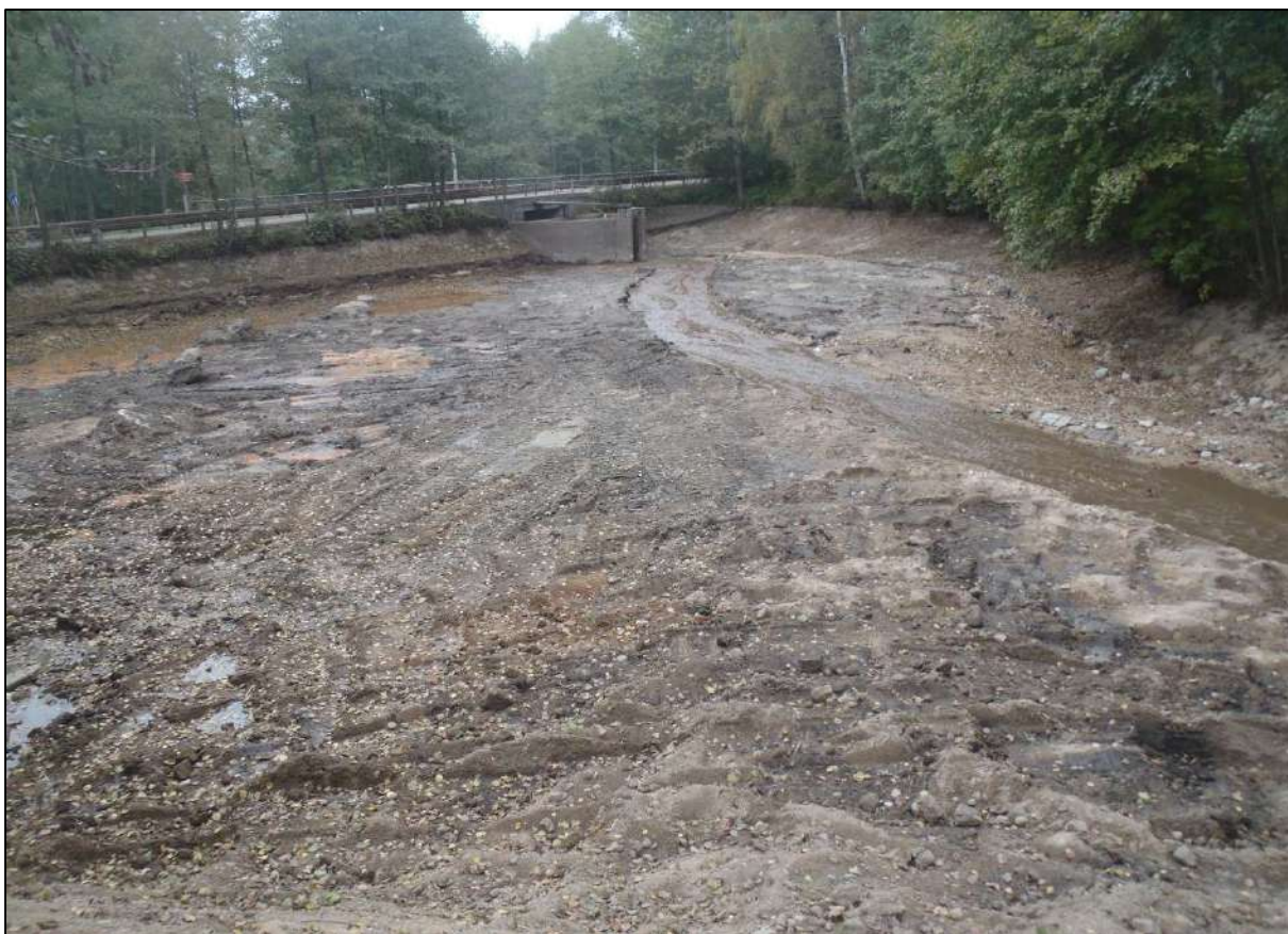
Obr. 1: Stav přehrážky krátce po předcházejícím odtěžení nánosů (9/2011)
