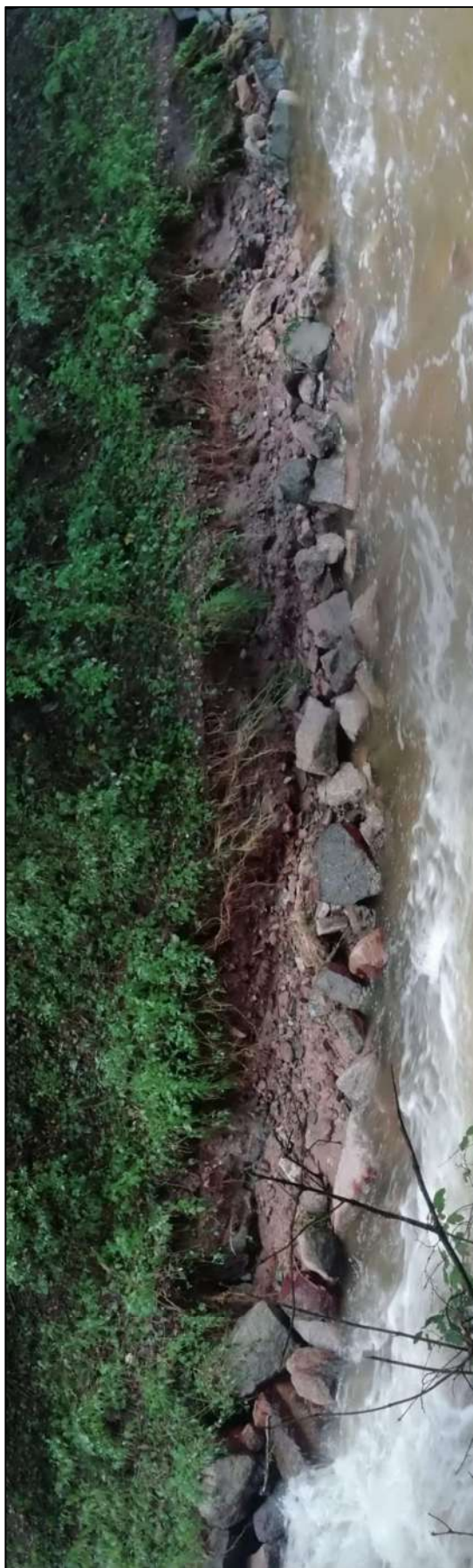
Obr. 11: Celkový rozsah poškození LB rovnániny v nátoku do zátopy hlavní nádrže VD Fojtka (9/2024)
