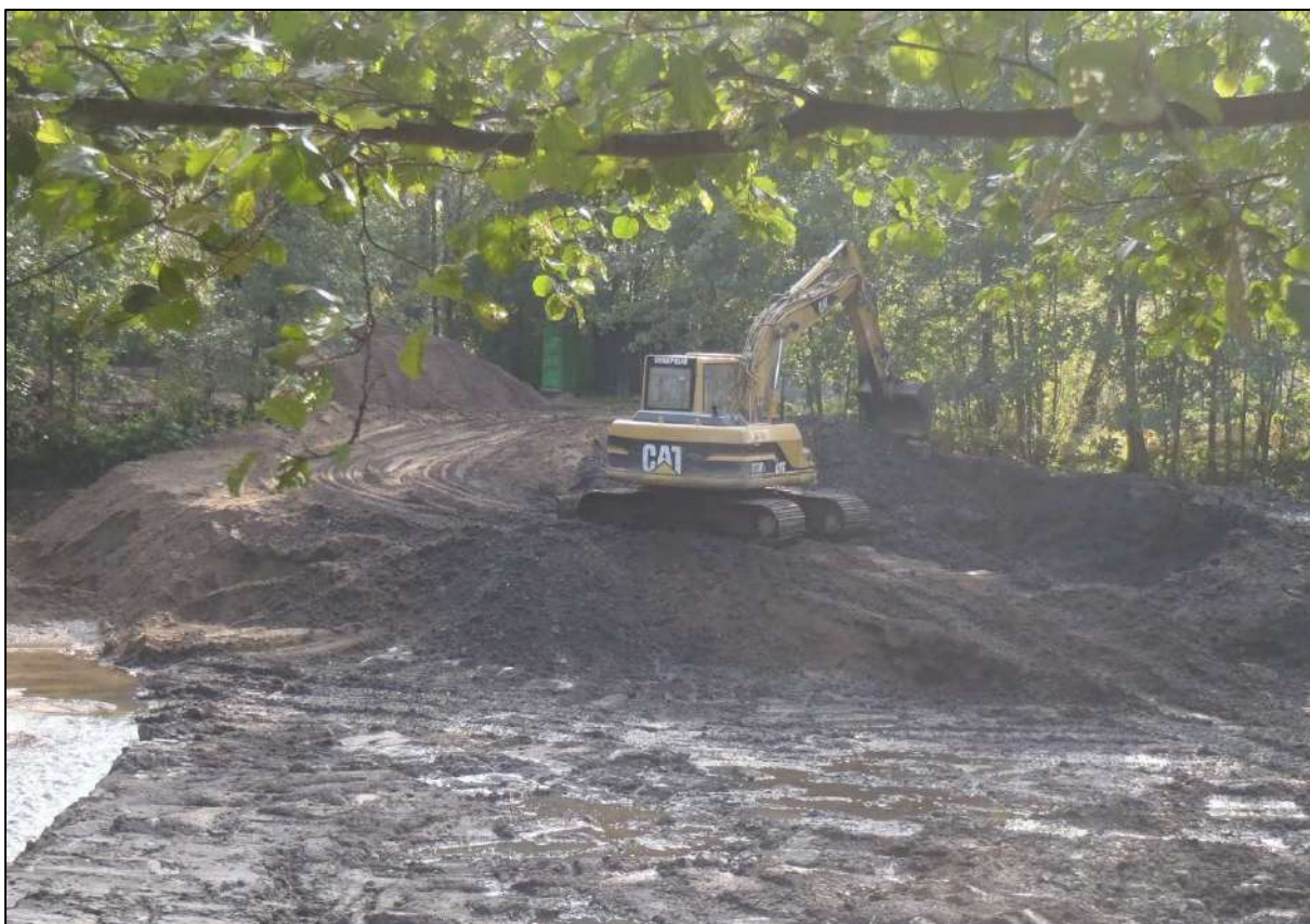
Obr. 5: Průběh těžení přehrážky, shrnování středním rypadlem (14t) (9/2011)
