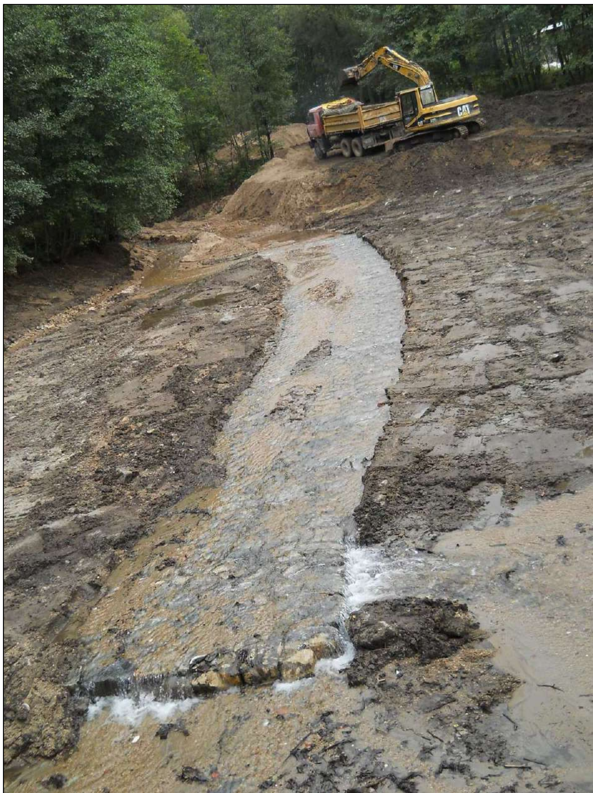
Obr. 4: Stav přehrážky během odtěžení nánosů – zřetelné opevnění dna toku s přesahem do dna nádrže (9/2011)
